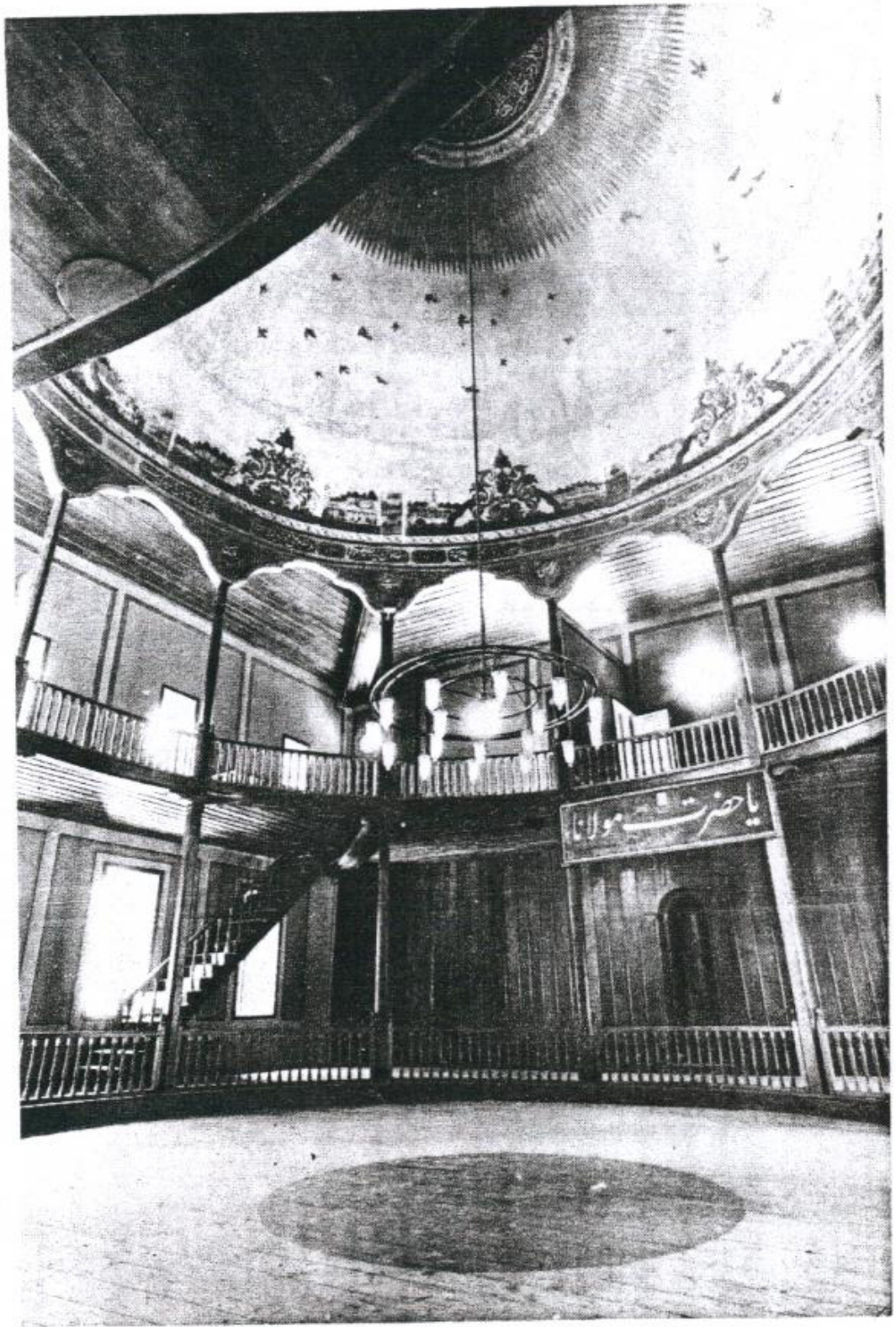
L'interno del sama' khana dopo il restauro داخل السمخانة بعد الترميم
