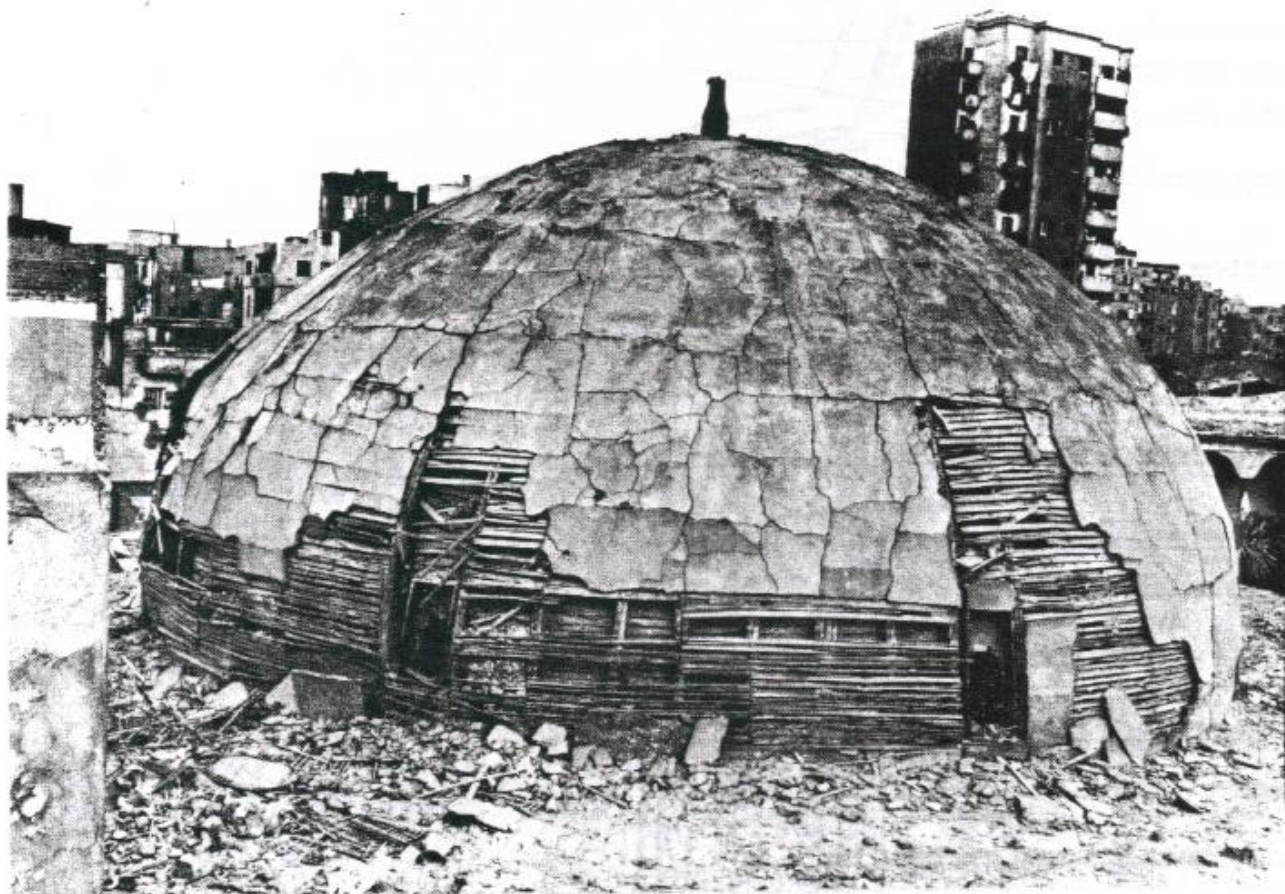
La cupola prima del restauro.
